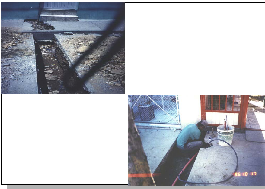
Figura 3.1 Apertura y sustitución de toma domiciliaria
